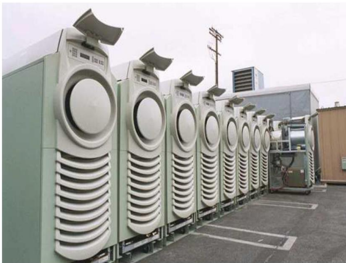
fol. 16 wysokowydajny energetycznie i ekonomicznie system energetyki rozproszonej oparty na systemach kogeneracji uzyskuje się energię elektryczną i ciepłą
