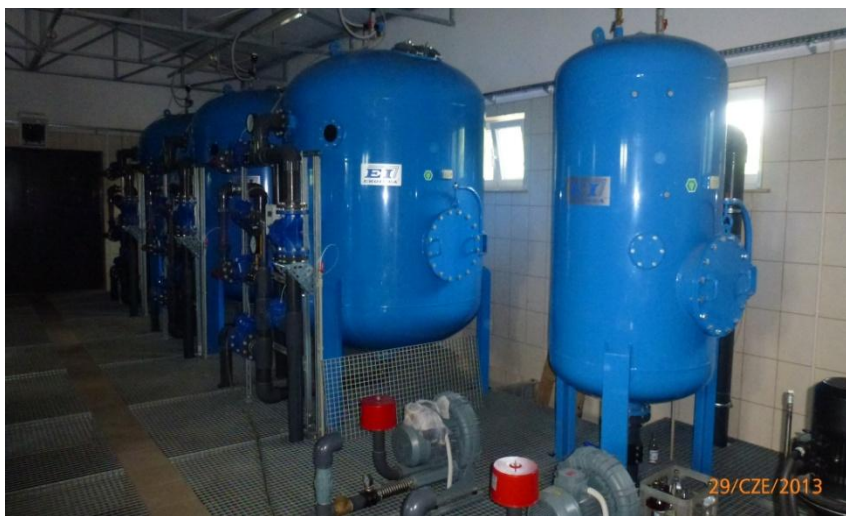
fot. 14 ujęcie i uzdatnianie wody zrealizowane w technologii filtracji dwustopniowej ciśnieniowej – widoczne zbiorniki wyrównawcze – zdolność produkcyjna 47m 3 /h
