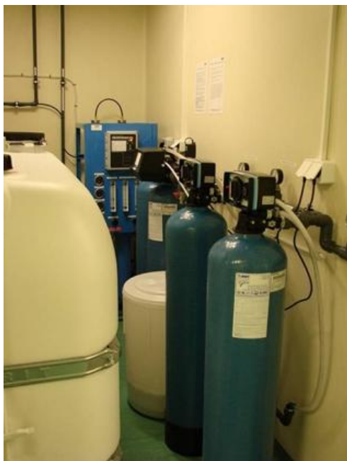
fot. 11 prezentacje stacji uzdatniania wody o stosunkowo nie wielkich wielkościach produkcyjnych np. na potrzeby sterylizatorni czy laboratorium analitycznego
